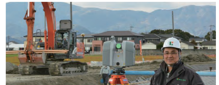
i-Construction現場でTrimble TX8の性能を見定めるICT事業部課長 藤本様
