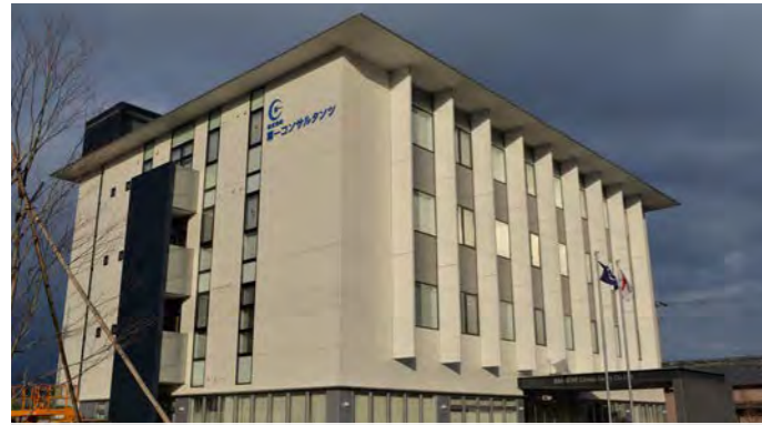
万全の体制づくりに備え平成27年に新設された第一コンサルタンツ様社屋。
