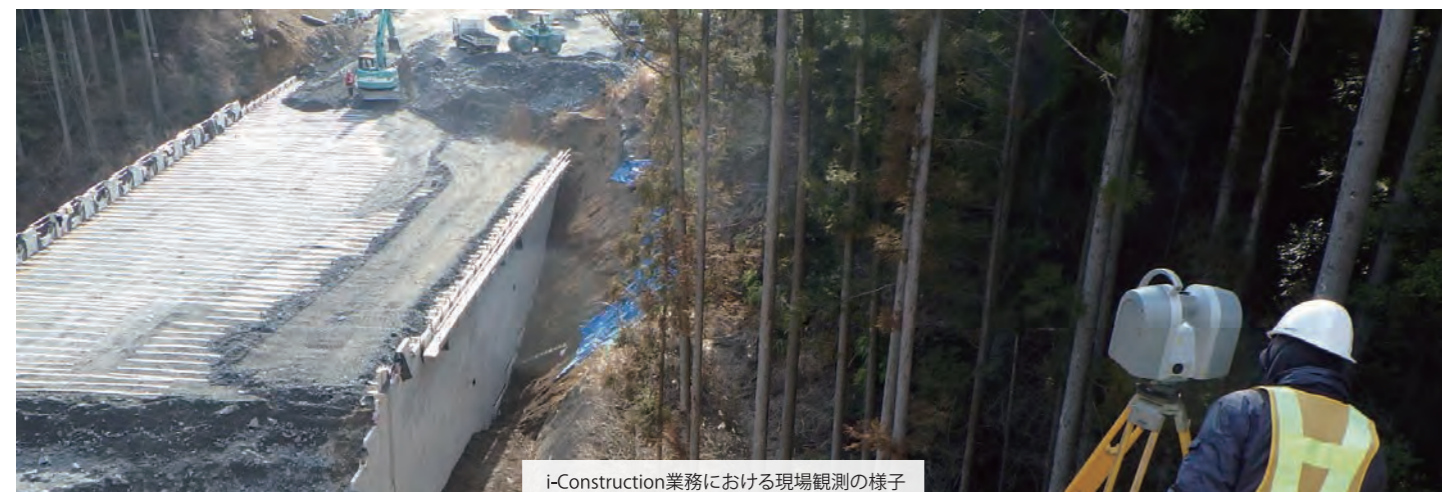
i-Construction業務における現場観測の様子
