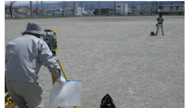
ここ石プロジェクトによるTrimble S6を利用した校庭へのトラック設置
