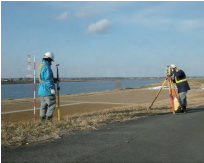
一級河川堤防におけるTrimble S6を使った河川横断観測
